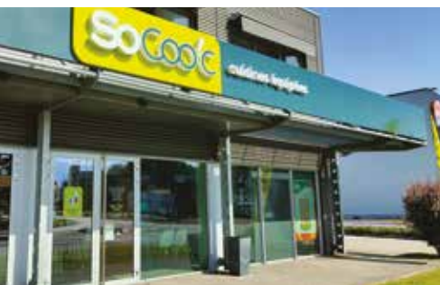
Le magasin de Valence a réouvert ses portes en juin après plusieurs semaines de travaux.
