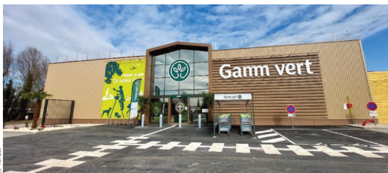
Façade du magasin Gamm vert de Béthune (62).
